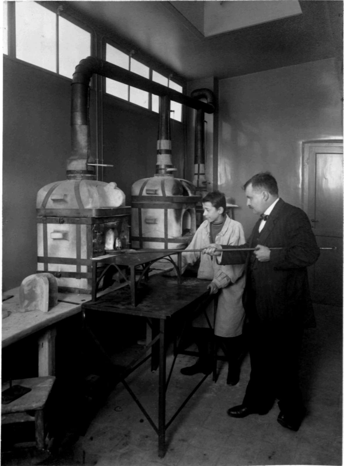
Installation de fours à coke avec mouffles interchangeables.
